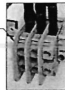
Detalhamento de separação dos bornes sak para cabos até 10mm² ESC.: S/E
