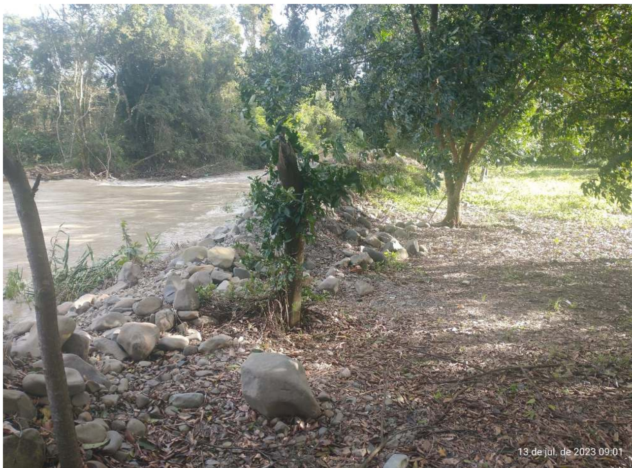
Imagem 3: pedras como contenção de enchentes e sem vegetação.
