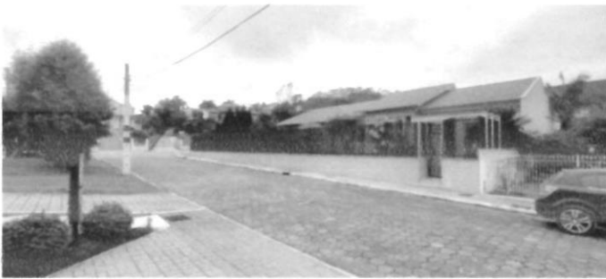
Foto 3: Vista frontal pela rua 13 de agosto
