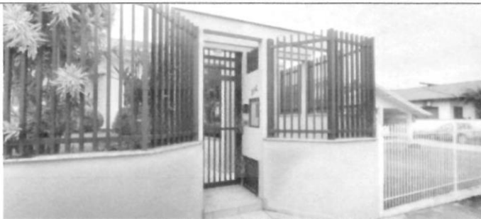
Foto 5: Portão de acesso
