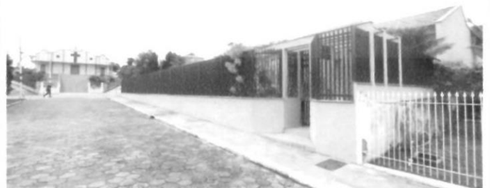
Foto 4: Vista acesso pedestres
