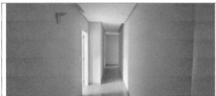
Foto 11: Circulação de acesso aos dormitórios
