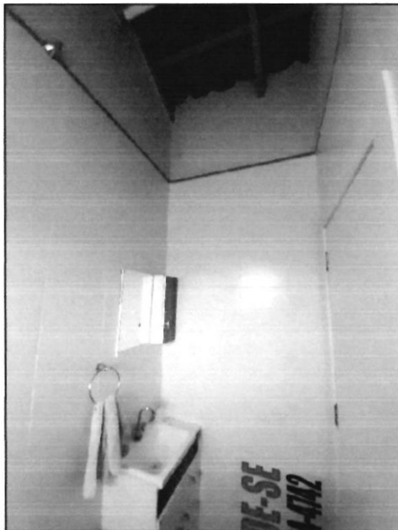
Figura 41 - banheiro de serviço.
