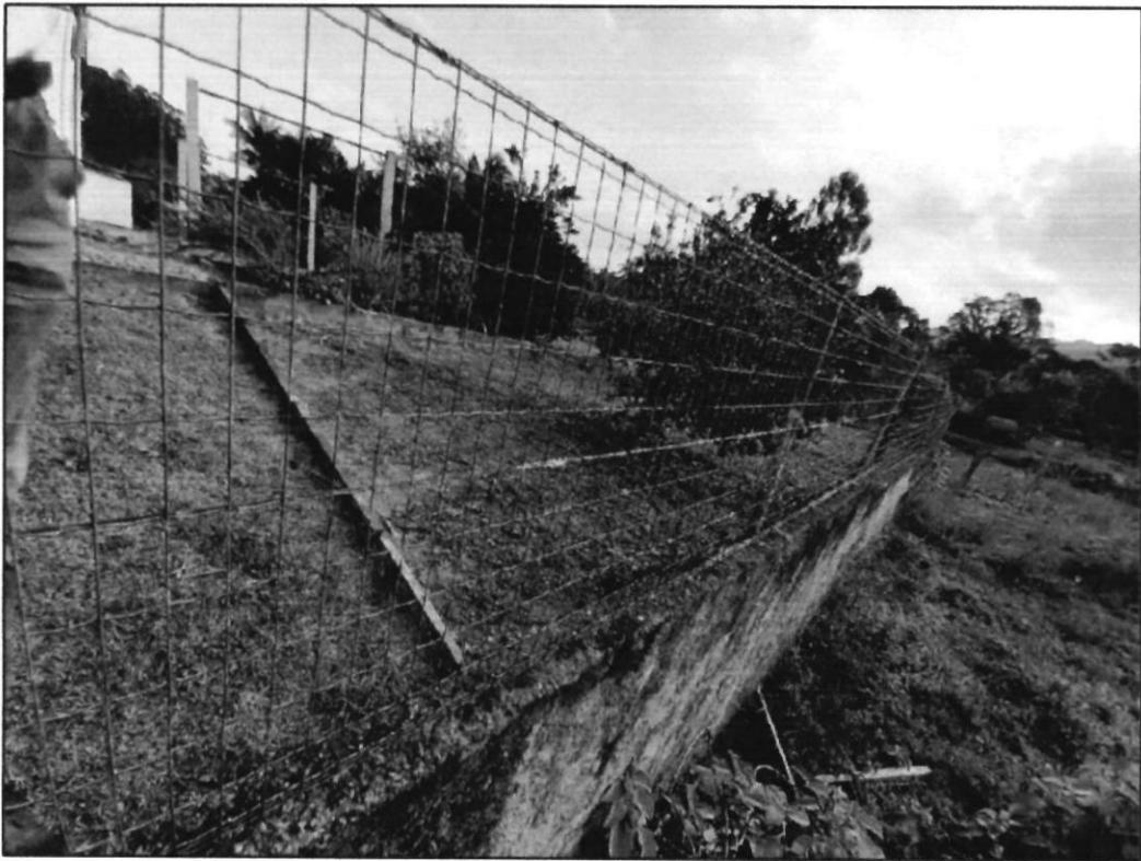
Figura 12 - muro divisa direita.
