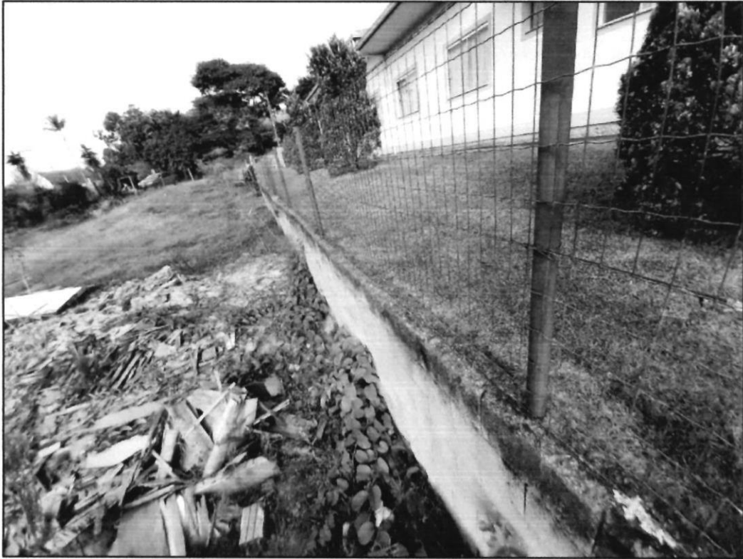
Figura 11 - muro divisa direita.
