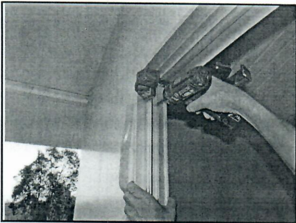
Figura 50 – Fixação da janela com parafuso.
