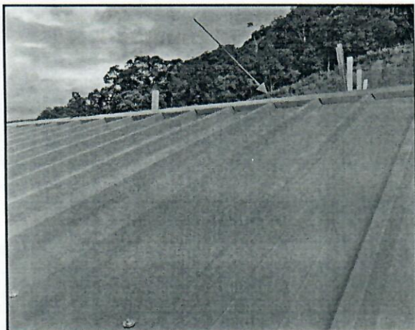
Figura 83 – Instalação da cumeeira.
