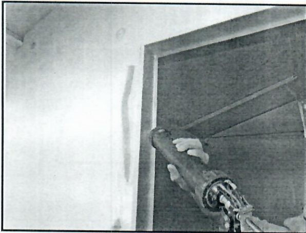
Figura 48 – Aplicação de selante na parte interna do batente.
