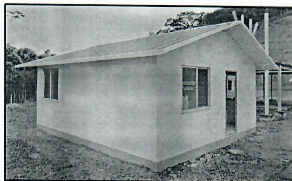
Figura 2- Casa em construção.
