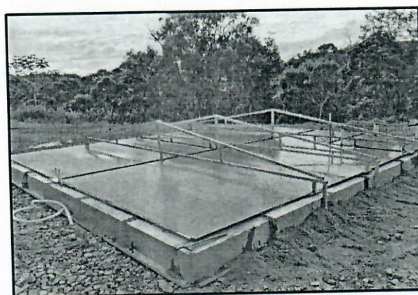
Figura 75 – Radier após concretagem e superfície acabada.
