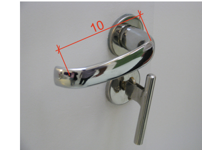
DETALHE MAÇANETA PORTA: TRINCO DE ALAVANCA ARREDONDADO (COM CHAVE ADAPTADA)
